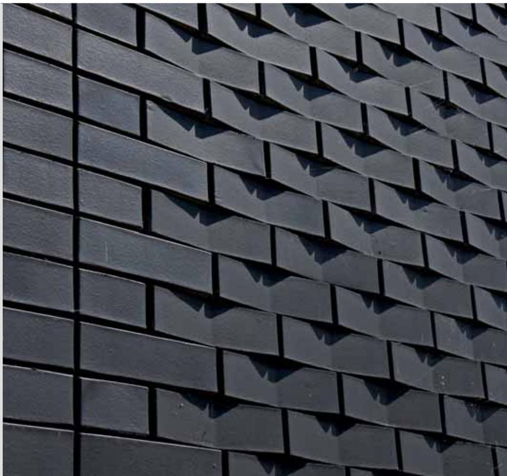
Ansicht von vorne: Schattenklinker ohne Mörtelfuge geklebt
