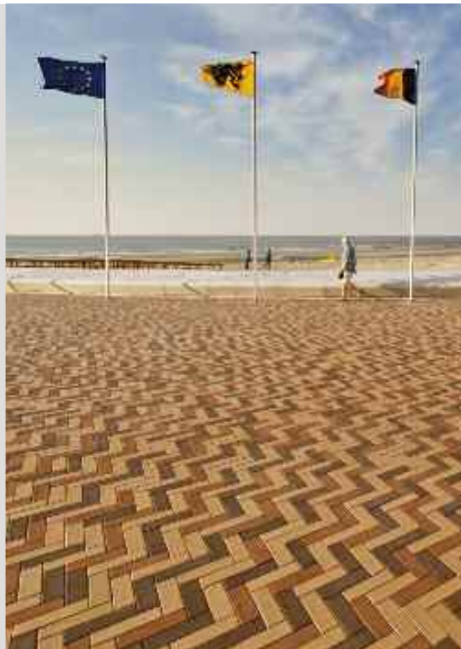
Strandpromenade mit Betonbrüstung/Ufermauer
