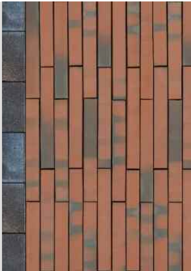
Langformat Recker bunt · Hochkantverlegung
