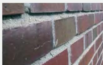
den. Eine tief zurückliegende Fuge beispielsweise verstärkt die Licht- und Schattenwirkung durch dunklen Schattenwurf. Bündig mit der Mauerwerks-oberfläche ausgebildete Fugen werfen keinen Schatten, betonen aber dafür die Gesamtfläche der Wand. Technisch die beste Lösung stellt die voll und
