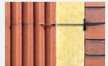
Mit den Hochleistungsdämmstoffen aus Polyurethan ( $\lambda = 0,024 \text{ W/mK}$ ) kann zweischaliges Verblendmauerwerk bei sehr guten Dämmeigenschaften relativ schlank aufgebaut werden.
