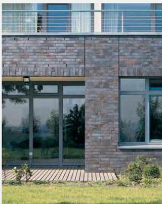
*Fertigteilstürze werden durch vertikale DF vom angrenzenden Pfeiler getrennt.*
