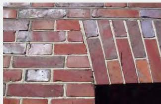
Die Aufnahme der horizontalen Lasten erfolgt über die Widerlagerschräge des Bogens.
