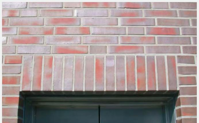
Sturz im Ziegelverblendmauerwerk aus „gemauerte Rollschicht“ (Grenadierschicht)
