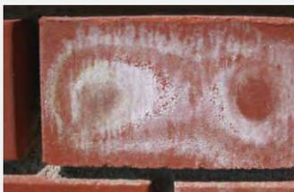
*Ausblühungen an einer Fassade aus saugfähigen Vormauerziegeln, verursacht durch Reinigung mit Salzsäure.*
