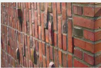
der individuellen Gestaltungsvielfalt des Sichtmauerwerks. Während bei der Baustoffwahl für die tragende Innenschale die konstruktiven und wirtschaftlichen Aspekte entscheidend sind, ermöglichen Vormauerziegel und Klinker als Sichtmauerwerk durch ihre Farbvielfalt und ihre Oberflächenstruktur und -texturen eine fantasievolle Architektur.
