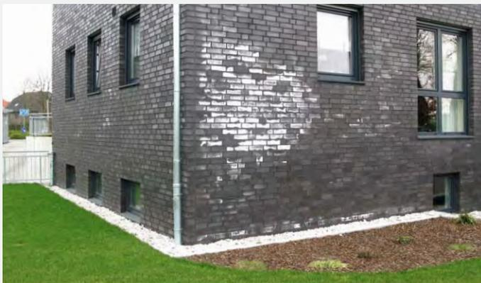
*Vorübergehende Ausblühungen bei einer neu errichteten Ziegelfassade als Folge einer permanenten Durchfeuchtung des Mauerwerks während der Bauphase.*
