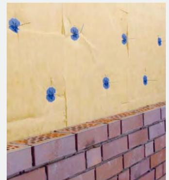
Die Außenschale wird auch als Vorsatzschale, Verblendschale oder auch Verblendmauerwerk bezeichnet, so dass sich der Sammelbegriff Verblendschale und Verblender einbürgerte. Das nur sich selbst tragende Verblendmauerwerk ist durch Edelstahlanker mit der tragenden Innenschale befestigt. Zwischen den beiden Wandschalen angeordnete Wärmedämmschichten optimieren den Wärmeschutz.
